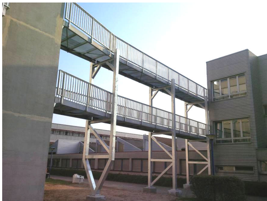
Mise en sécurité incendie du Lycée Goulden de Bischwiller – lot passerelle Région Grand Est – Maître d'œuvre ARCHETYPE – OPC SRIG Ingénierie
