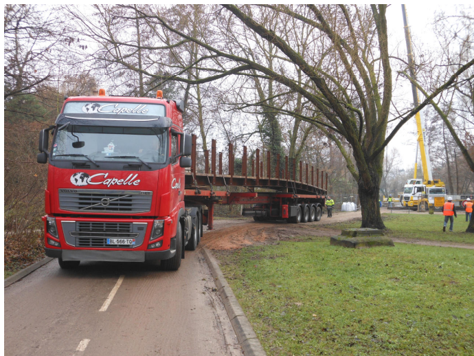
Strasbourg, passerelle sur le Mühlbach, à son embouchure avec l'Ill (Maître d'ouvrage : CUS / Maître d'œuvre : Serue) longueur 22,70m, largeur utile 2,08m, vue lors de la livraison et de la pose par grutage
