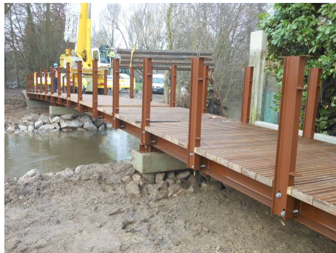
Strasbourg, passerelle sur le Mühlbach, à son embouchure avec l'Ill (Maître d'ouvrage : CUS / Maître d'œuvre : Serue) longueur 22,70m, largeur utile 2,08m, vue lors de la livraison et de la pose par grutage
