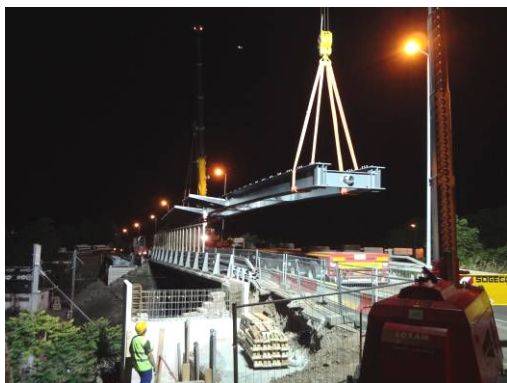
Sélestat, passerelle du Sand, L=89,20m, vue lors du grutage nocturne et vue terminée Ville de Sélestat – maîtrise d'œuvre SNCF
