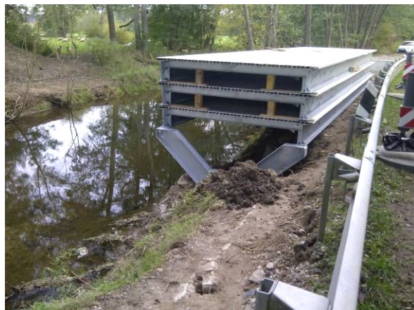
Voie cyclable surplombant la Sarre, près de Sarrebourg (en cours de pose) Communauté de Communes de la Vallée de la Bièvre
